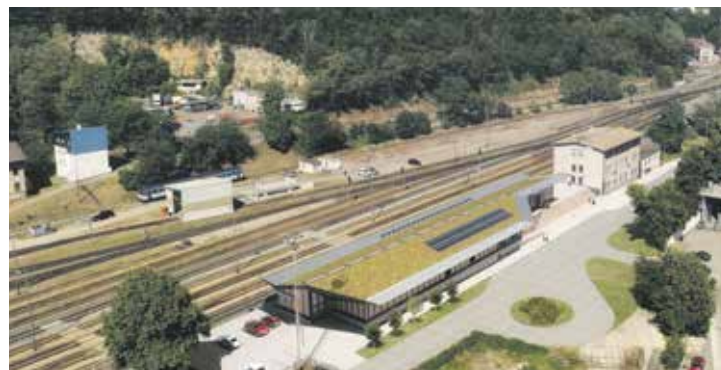
Boleslavské nádraží bylo historicky vnímáno jako zanedbaná část města. Po dokončení rekonstrukce výpravní budovy má být důstojným prvním i posledním místem kontaktu cestujících s městem. Foto | Správa železnic
