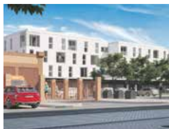
Práce by měly být dokončeny v červenci letošního roku. Zdroj | město Veselí nad Moravou
