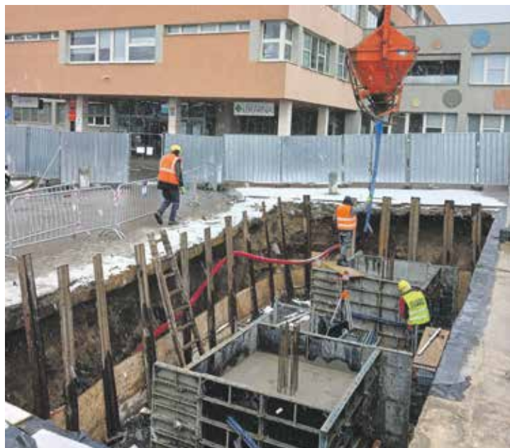
Stavba administrativního objektu, kde by měla dočasně sídlit Zdravotnická záchraná služba hl. m. Prahy, v areálu Polikliniky Prosek. Foto | mj
