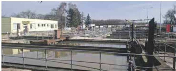
Čistírna odpadních vod ve Kbelích projde rekonstrukcí za téměř 388 milionů korun. Kapacita zařízení se téměř ztrojnásobí. Zdroj | PVK
