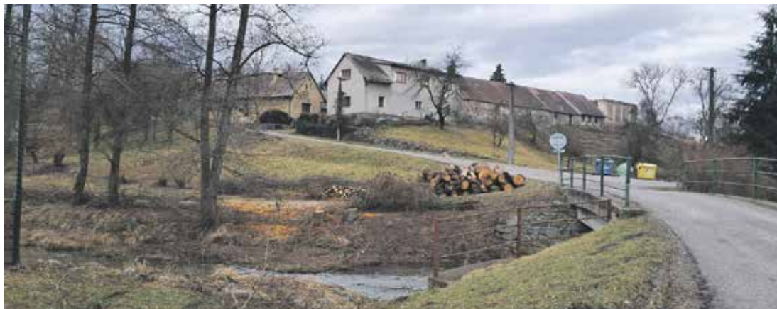
Starý most v Krusičanech nevyhovuje současnému dopravnímu zatížení. Nově postavený most bude mít nosnost 26 tun. Foto | město Týnec nad Sázavou
