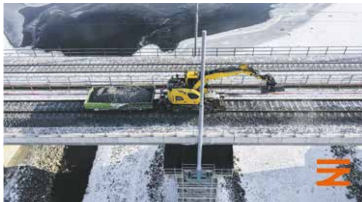
Stavební práce na modernizaci tratě nezastavil ani sníh. Foto | Správa železnic
