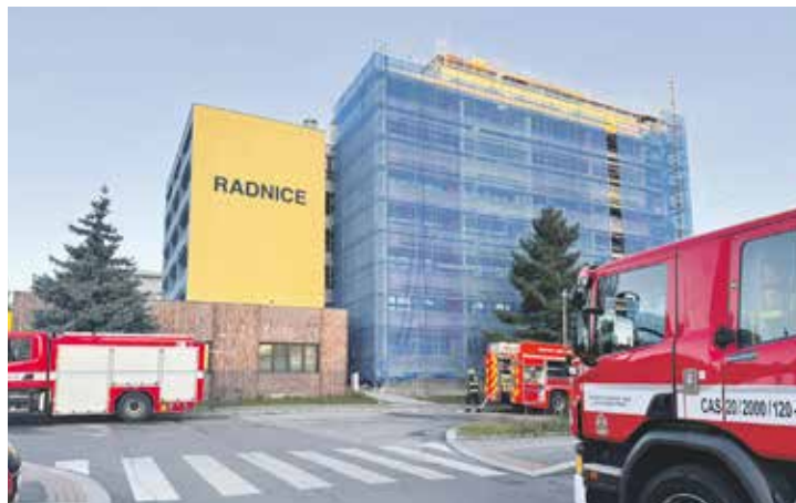
Budovu poničil nejen požár, ale také voda, kterou oheň hasili. Foto | Hasiči Praha
